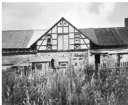
In DDR-Zeiten dem Verfall preisgegeben: 1998 präsentiert sich die Anlage abbruchreif
