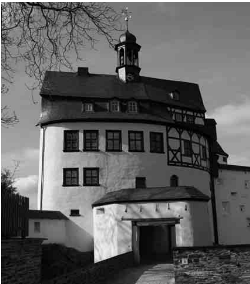
Alte Mauern in neuem Gewand. Das frisch sanierte Amtshaus auf Schloss Burgk ist mehr als nur historische Fassade. Foto: Kristin Pfeiffer-Geheeb, Pressestelle Landratsamt Saale-Orla-Kreis
