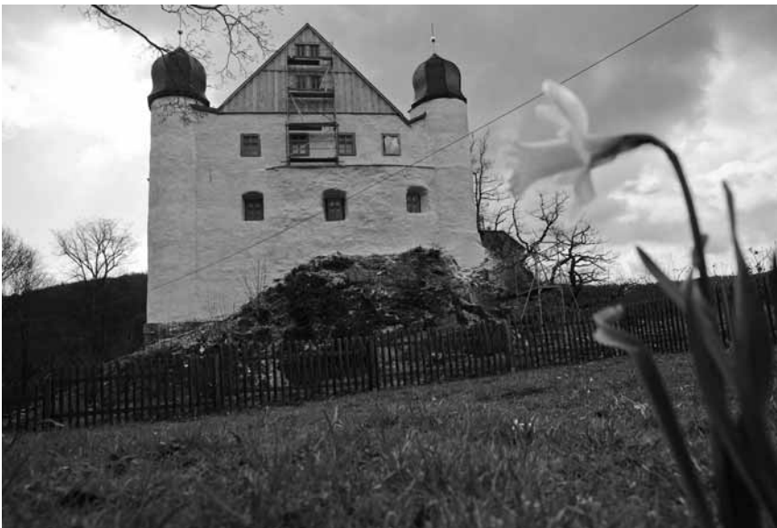
Wiederhergestellt ist das Zeughaus in Schwarzburg. Die Stiftung Thüringer Schlösser und Gärten hat das Gebäude in den vergangenen Jahren saniert, 2015 soll es die kostbare Schwarzburger Waffensammlung beherbergen, die dem Thüringer Landesmuseum Heidecksburg gehört.
