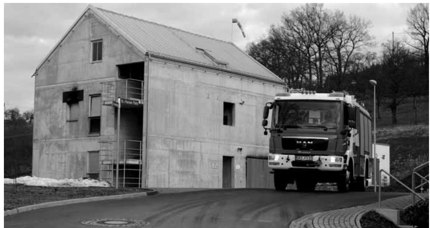
Das Übungshaus mit der Brandsimulationsanlage wird seit 2009 genutzt. Hier erfolgt die „Heißausbildung“ mittels computergesteuerter Brandszenarien. Foto: H. Heß
