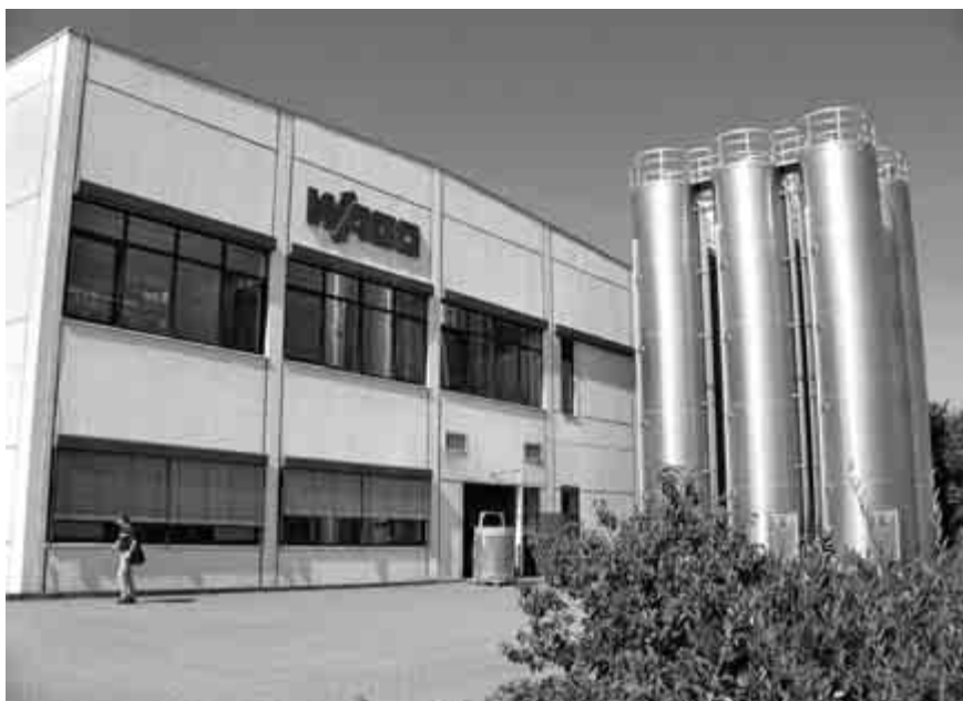
Die WAGO Kontakttechnik GmbH & Co. KG ist der größte Arbeitgeber der Region
