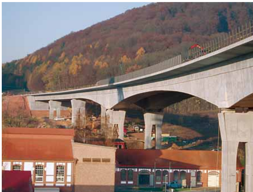
Die Friedetalbrücke im Herbst 2009 – Ansicht von Südost
