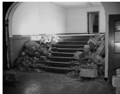
Bauarbeiten in der Adolf-Reichwein-Schule Foto: Stadt Jena
