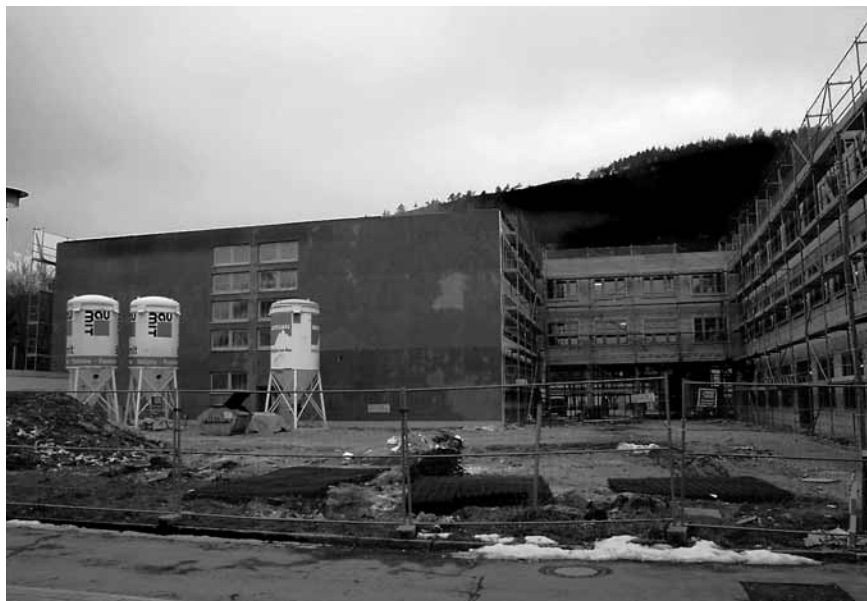
In Arbeit: das Berufsschulzentrum Jena-Göschwitz
