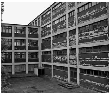
Goetheschule in Jena unsaniert Foto: Stadt Jena
