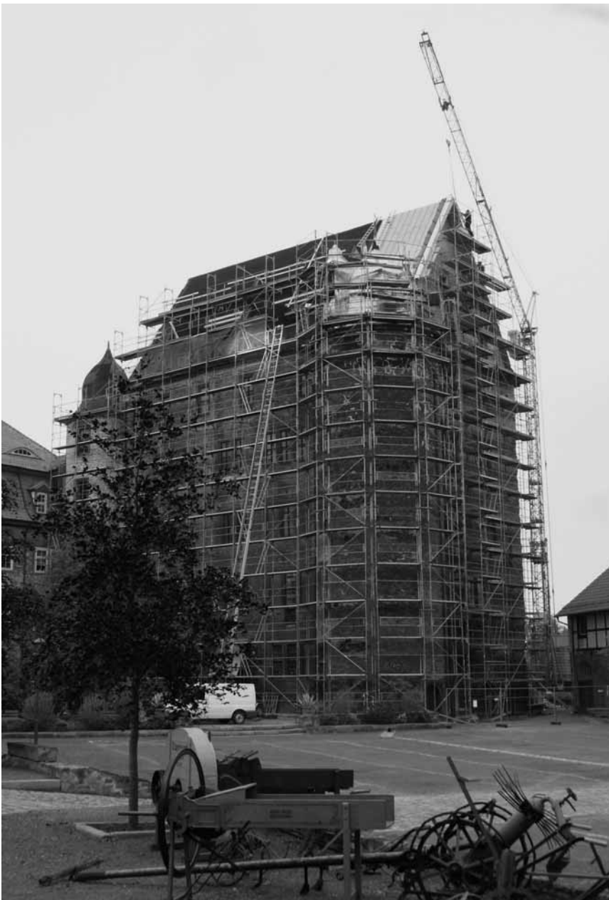
Schimmer in der Goldenen Aue – zurzeit wird das Dach mit Kupfer abgedeckt
