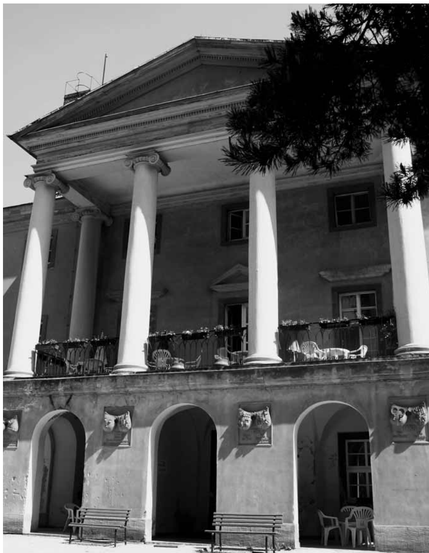
Der Blickfang des Schlosskomplexes: Das Portal. Der Giebel lässt sich nicht mehr restaurieren und wird originalgetreu nachgestaltet.
