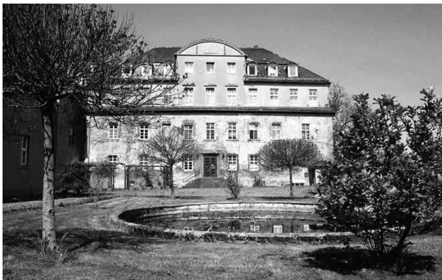
Ansicht des Stift-Gebäudes von der Hofseite aus: Der Stift wird erhalten und saniert. Die oberste Etage wird abgetragen, um den originalgetreuen, denkmalgerechten Zustand von 1907 herzustellen.
