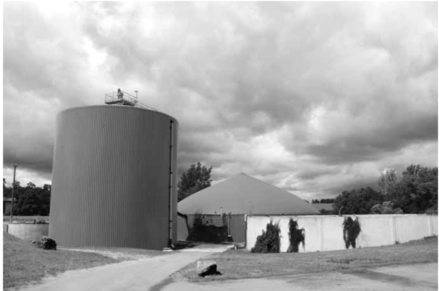
Die Biogasanlage in Schkölen produziert Strom und beheizt Schweineställe und Büros. Bald soll noch eine Fischzuchtanlage hinzukommen.
