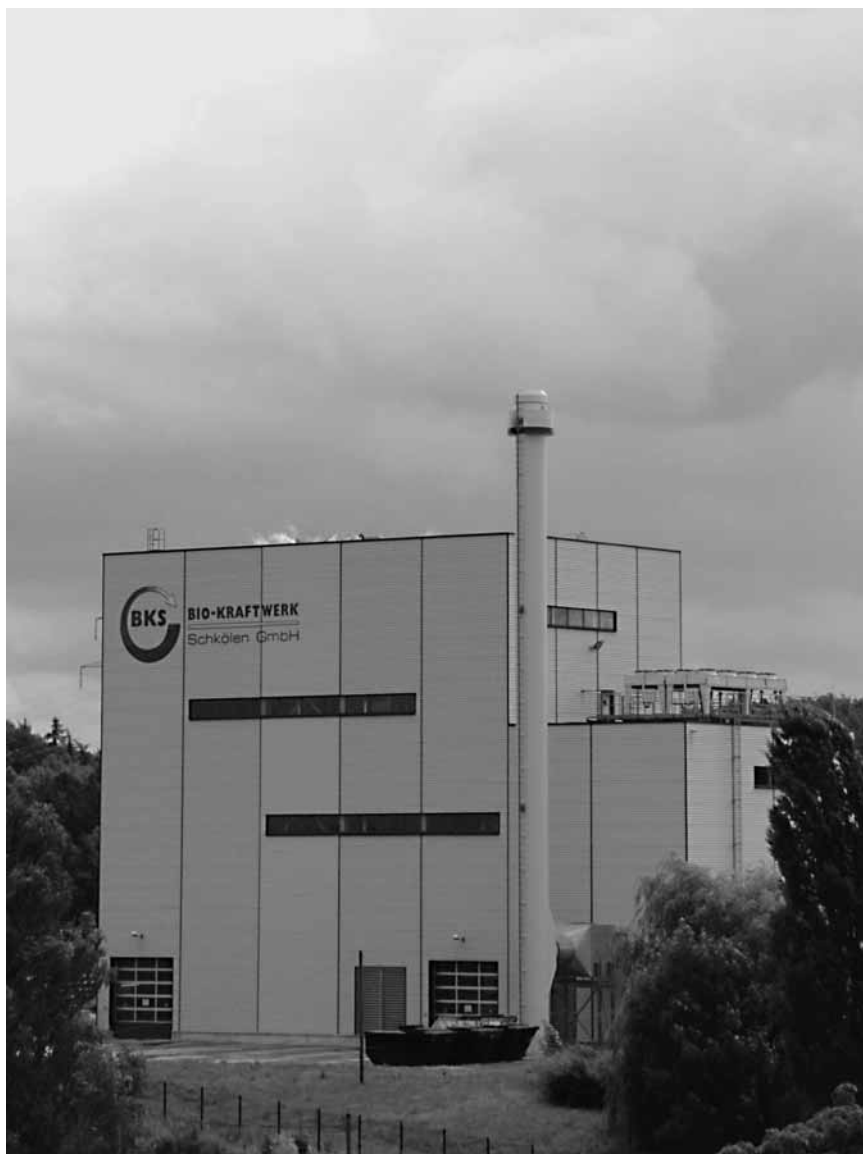
Das Biomasse-Kraftwerk in Schkölen
