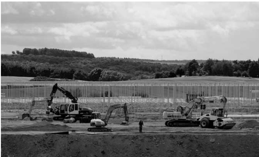
Hier entsteht ein Gewächshaus, das die überschüssige Kraftwerkswärme und sogar das CO 2 gut gebrauchen kann
