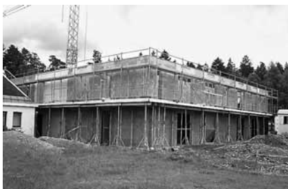
Baubestand des Neubaus des Kinderhospizes, Juni 2009 Foto: Stephan Masch
