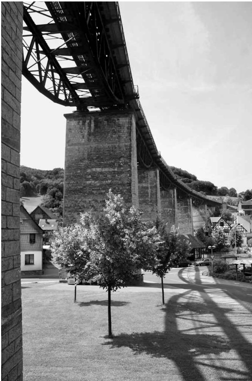
Das einmalige, den ganzen Ort Lengenfeld unterm Stein überragende, 23 m hohe Viadukt
