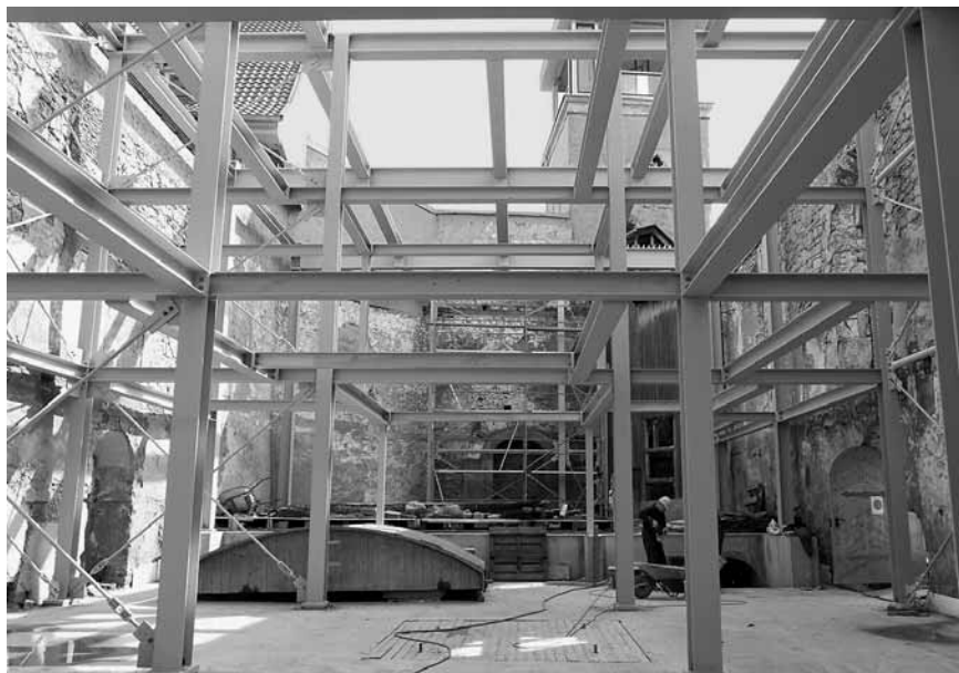
Im Sommer 2008 erfolgte der Einbau der komplizierten Tragkonstruktion, OG-Decke und Notabdichtung Foto: LRA Kyffhäuserkreis (Antje Burghardt)
