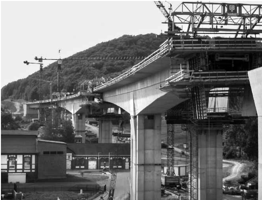
Friedetalbrücke – Freivorbau des südlichen Überbaus (Richtungsfahrbahn Halle)
