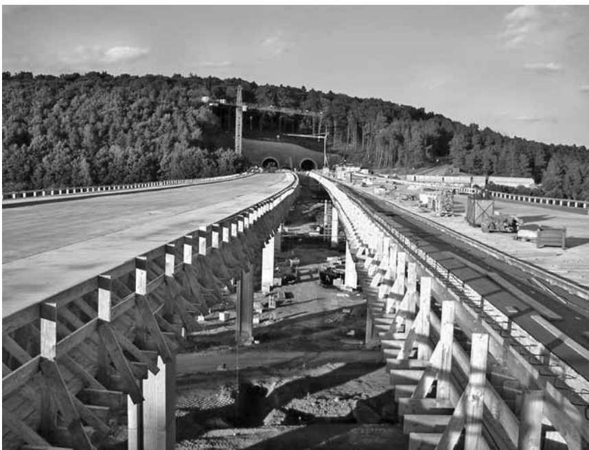
Rhintalbrücke mit Blick in Richtung Westportal Tunnel Höllberg
