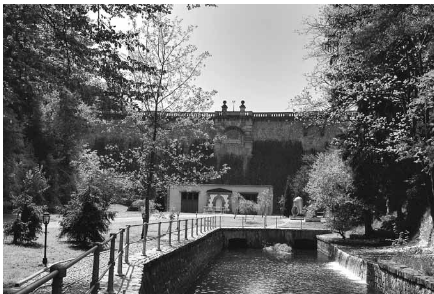
Alte Tambacher Talsperre
