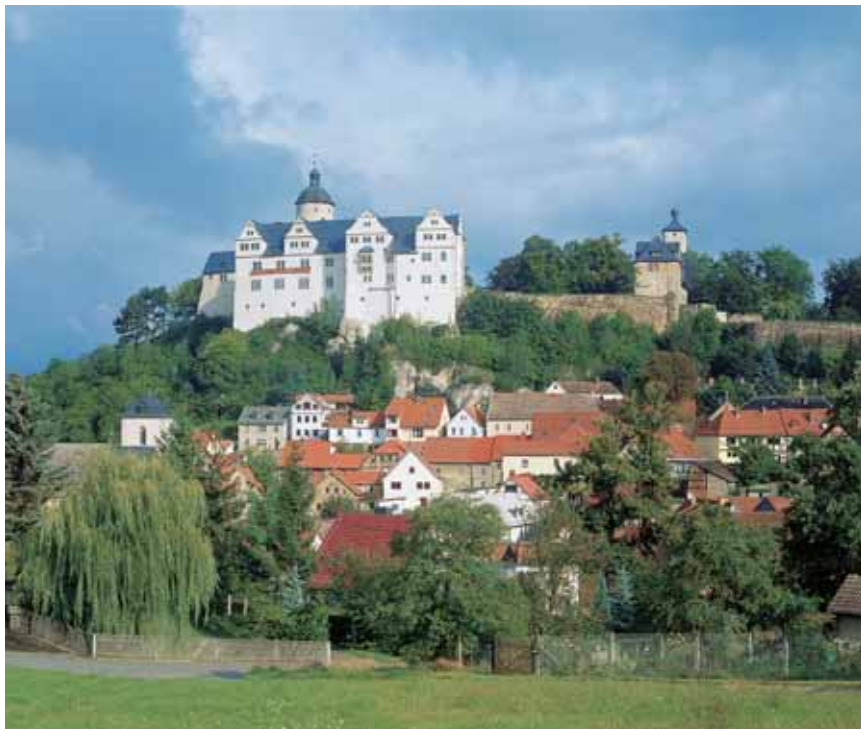
Burg Ranis, Ansicht von Süden
