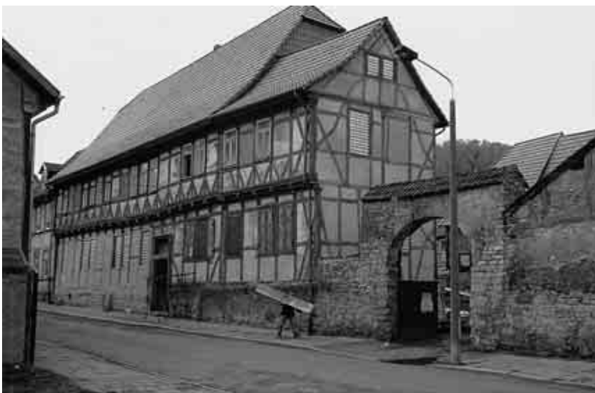
Die „Alte Kanzlei“ in Bleicherode
